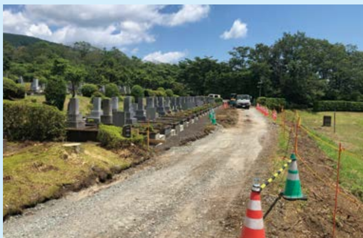
2区1号外周道路の工事画像
