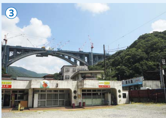
③ 山北町川西の国道246号線清水橋交差点付近から、河内川にかかる河内川橋（仮称）。河内川橋は川面からの高さが125m・橋脚と橋脚の間隔は220mあり、バランスドアーチ橋としてはどちらも日本最大級です。
