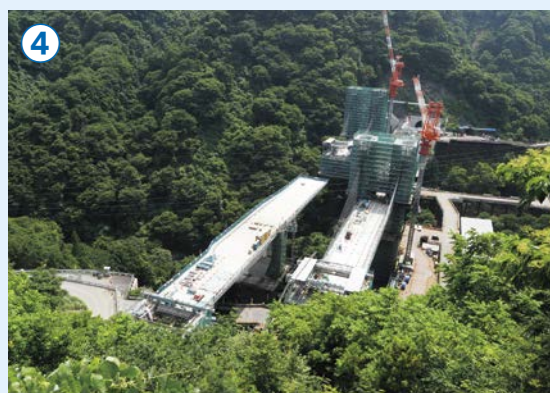
④ 松田町寄から、やどりき双扇橋（中津川橋）。この橋の西側（画像では右上方向、山北・御殿場方向）が新東名高速道路建設における最難関工事の高松トンネルです。
