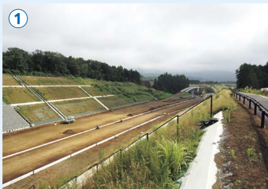
① 小山町用沢の「霊園入口」交差点北側から、新東名高速道路の本線と小山スマートIC（PA）への分岐付近の状況。本線路盤の舗装工が進められています。開通すると小山スマートICから霊園まで、車で約3分です。
