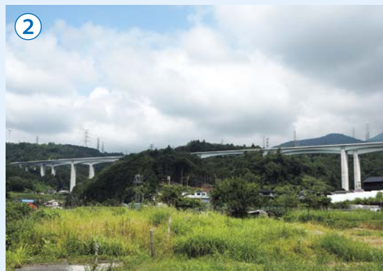
② 小山町中島の国道246号線中島IC付近から、北側に位置する湯船高架橋。高架橋はほぼ完成しています。
